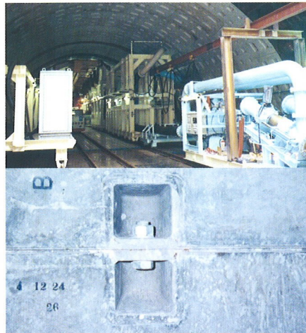
●シールドトンネル(セグメントボルト)
